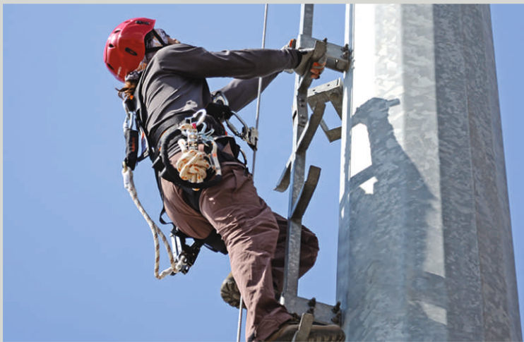
PRŮBĚŽNÉ VERTIKÁLNÍ JISTÍCÍ SYSTÉMY K ŽEBŘÍKŮM
